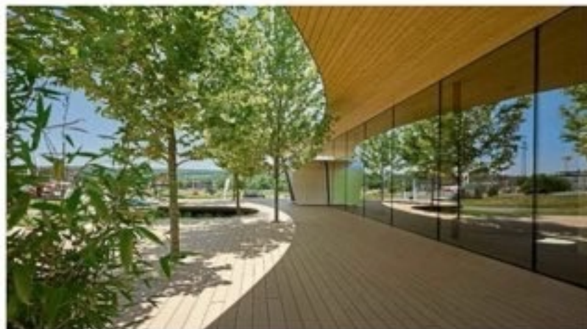
Aus Einlassungen in der Terrasse wachsen Bäume. Das sorgt für Schatten und ein angenehmes Ambiente.
