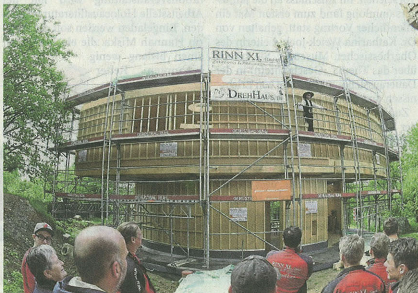
Am Drehhaus wird Richtfest gefeiert.
