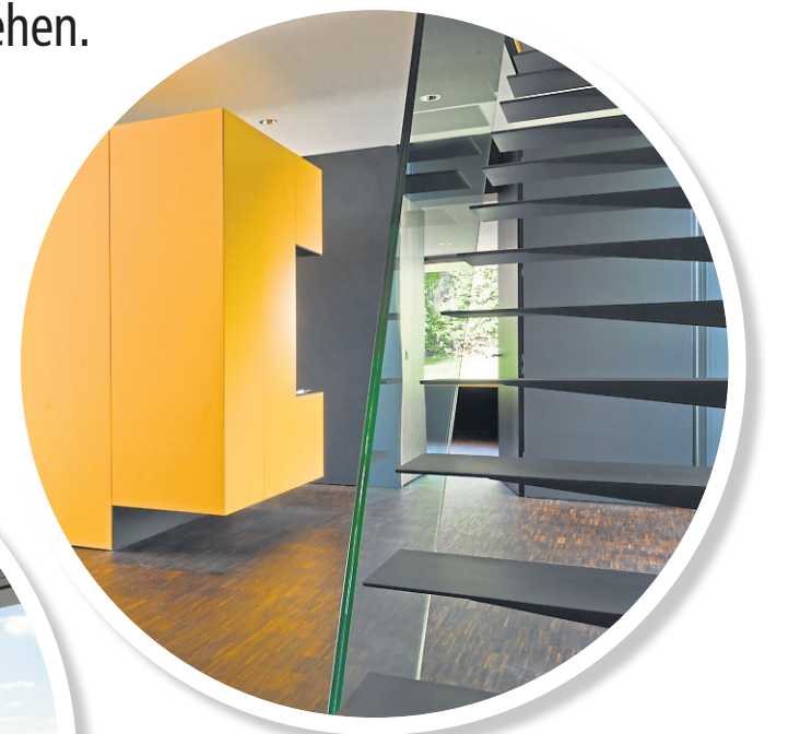
Die filigrane Treppe aus Metall erschließt die Wohnebene im Obergeschoss.
